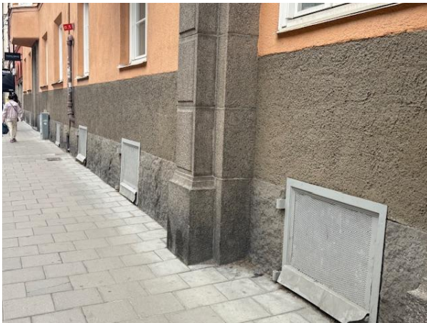
Sockel mot väster mot port 32
