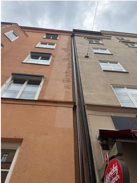
Utförd lagning vid stuprör mot hus 28 (2023)
